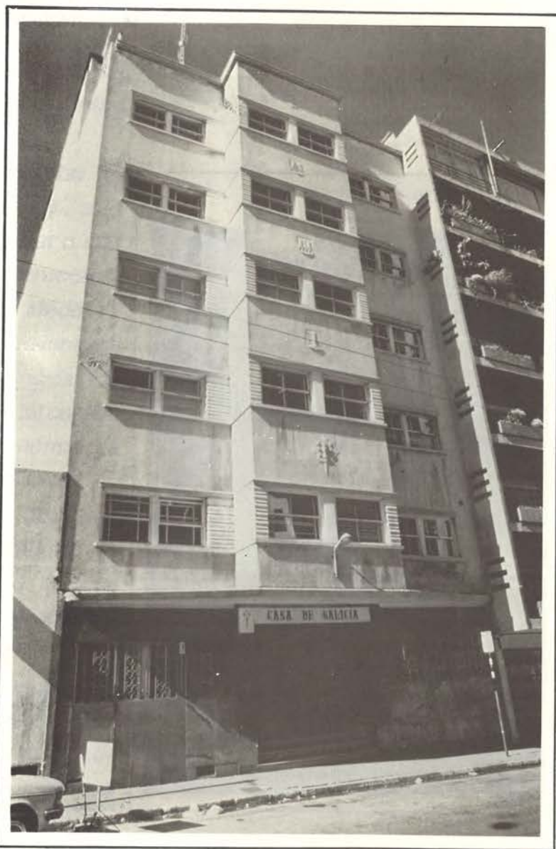
Policlínica Central, Fachada: Colonia 1474.
