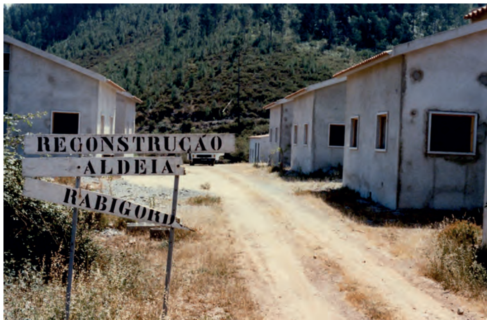
Fot. 2. Aspeto da fase de suspensão da reconstrução da pequena aldeia de Rabigordo (Fotografia de L. Lourenço, junho de 1991)
