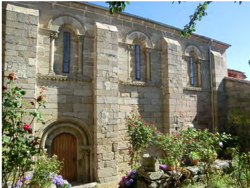
FOTOGRAFÍA 3: MURO SUR DE LA ANTIGUA IGLESIA MONÁSTICA DE SOBRADO DE TRIVES.
