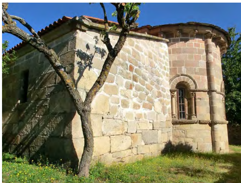
FOTOGRAFÍA 7: ÁBSIDE DE LA ANTIGUA IGLESIA MONÁSTICA DE SOBRADO DE TRIVES.
